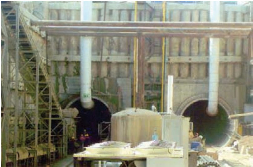
Монтаж армокаркаса конструкции «Стена в грунте» на строительстве станции «Мэмар Аджеми-2».
