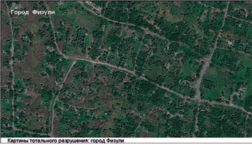
Картины тотального разрушения: город Физули
