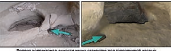
Подвод коллектора к емкости через отверстие под горловинной частью.
