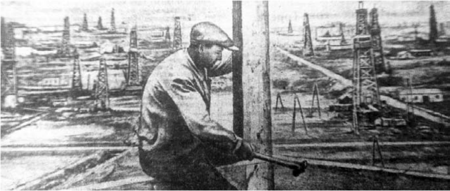
Один из лучших стахановцев строительной конторы треста Сталиннефть, бригадир вышекников тов.Тамбовцев работает на строительстве вышки №475. Новые технические нормы тов.Тамбовцев выполняет на 150—350 процентов.
