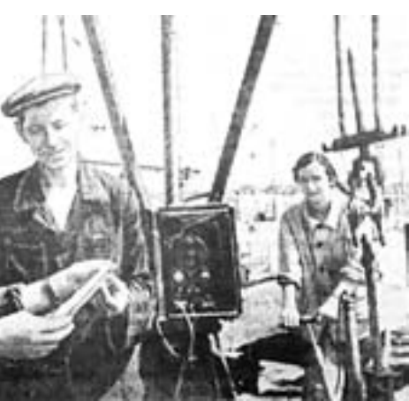
В передовой бригаде шестого промысла «Лениннефти». Начальник участка С.Габидуллаев, техник Т.Реснянский и оператор по исследованию И.Исмаилова определяют динамический уровень в скважине.
