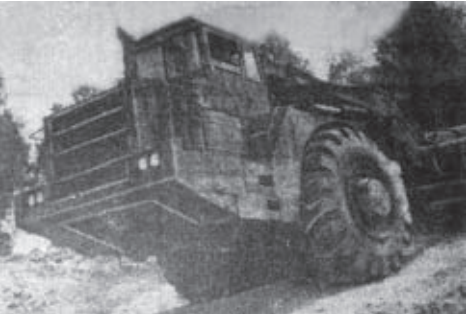
На снимке: скрепер «ДЗ-67» в момент набора грунта.
