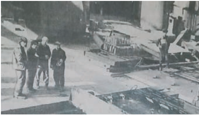
На снимке: укладчик комбинированных облицовок Фото Г.ФИРСТОВА
