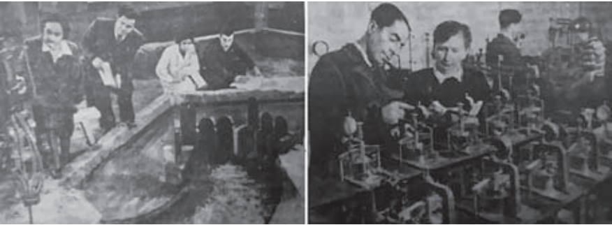
На снимках: 1. В гидротехнической лаборатории. Младшие научные сотрудники проводят испытания модели водозабора на реке Алджиганчай. 2. Заведующий геотехнической лабораторией А.Маггеррамов и младший научный сотрудник А.Бибарсова проверяют физико-механические свойства грунтов.
